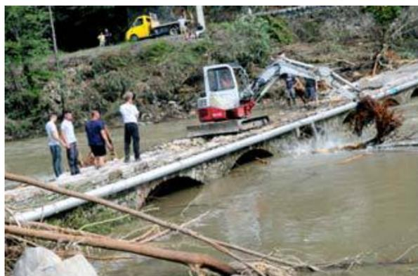
Les nombreux embâcles ont causé de gros dégâts, comme ici au pont du mas de La Cam.
