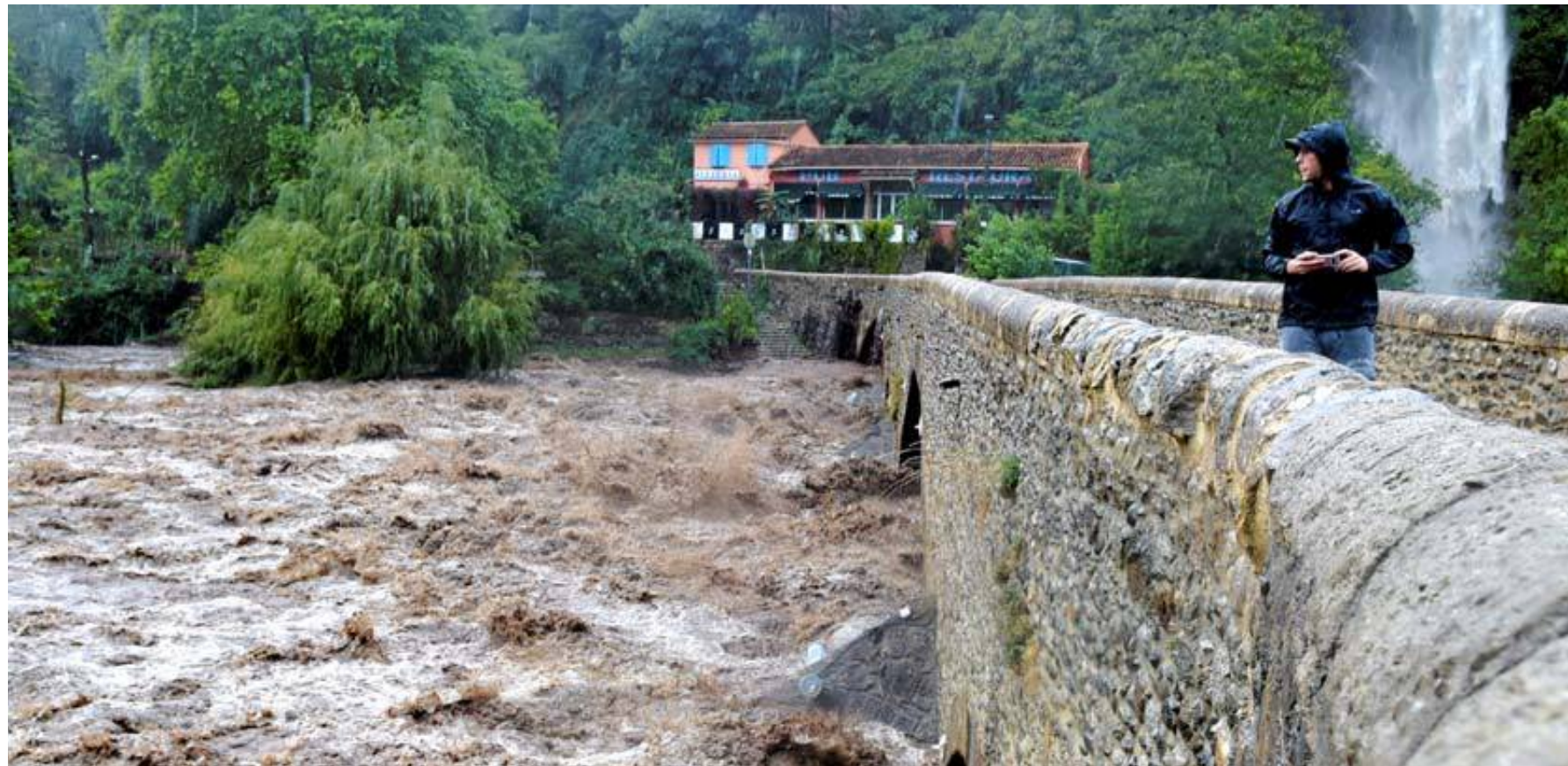
Les eaux en furie à Saint-Julien-de-la-Nef, dans le Gard, l'une des communes les plus fortement touchées par les intempéries.
